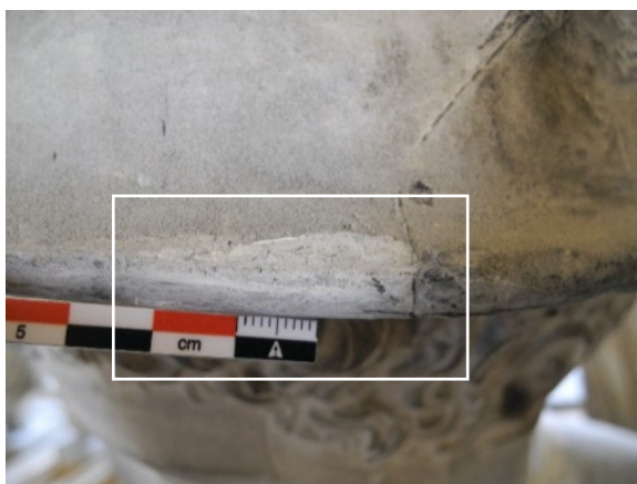
Figure 19 : exemple de comblement de petite dimension sur le bord du casque d'une figure d'Hermès de la gypsothèque (Gy 0185), ©Musée du Louvre, J. Robin Dupire.
