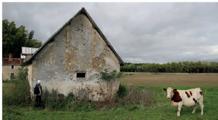
Figure 6 : La Bergerie de la Pommeraye, Rambouillet, enduits au plâtre ; tiré de Le Dantec, 2019.
