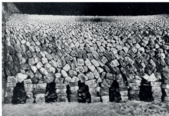
Figure 6 : Un four à plâtre avant l'allumage à Noisy-le-Sec, 1925, photographie d'A. Robin, tirée de Le Dantec, 2019, p. 97.
